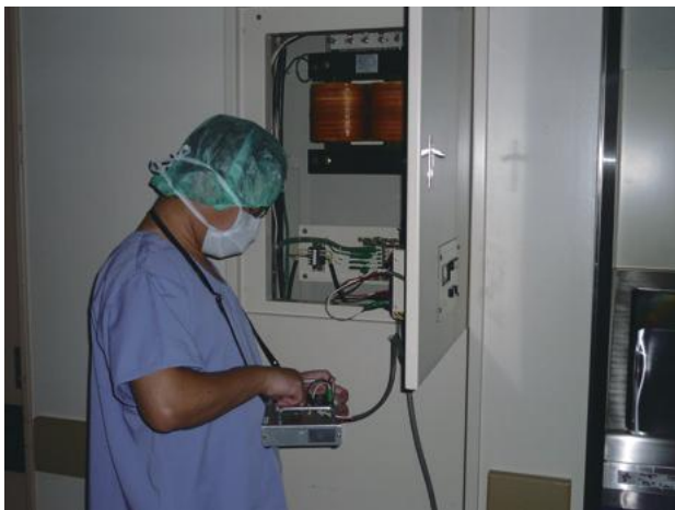
絶縁監視装置の動作試験
